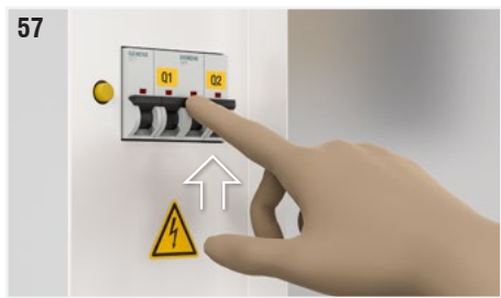
Fig. 57: Compruebe que los interruptores magnetotérmicos para desconectar la alimentación del ventilador (Q1) y desconectar la alimentación auxiliar (Q2) estén en la posición ON.
