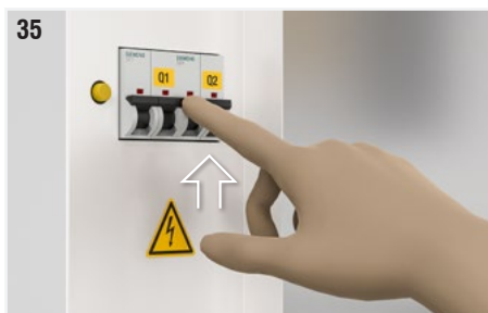
Fig. 35 : Vérifier que les interrupteurs magnétothermiques pour débranchement alimentation ventilateur (Q1) et débranchement alimentation auxiliaires (Q2) soient dans la position ON.
