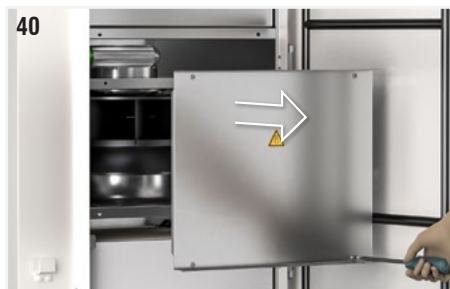
Fig. 40 : Retirer le panneau qui protège le ventilateur en dévissant les vis de fixation.
