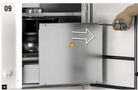
Fig. 9 : Retirer le panneau qui protège le ventilateur en dévissant les vis de fixation.
