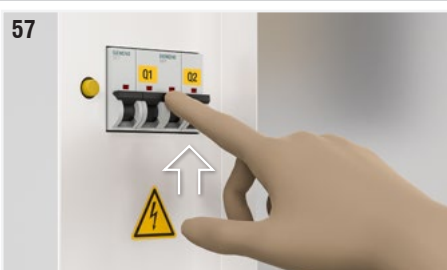
Fig. 57 : Vérifier que les interrupteurs magnétothermiques pour débranchement alimentation ventilateur (Q1) et débranchement alimentation auxiliaires (Q2) soient dans la position ON.
