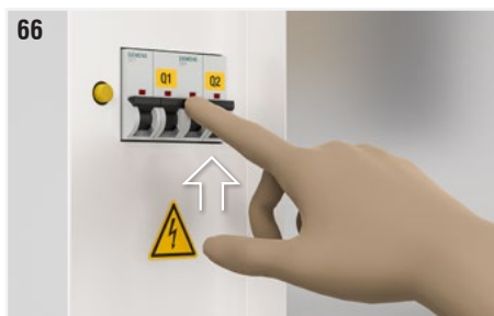
Fig. 66: Verificare che gli interruttori magnetotermici per stacco alimentazione ventilatore (Q1) e stacco alimentazione ausiliari (Q2) siano in posizione ON.
