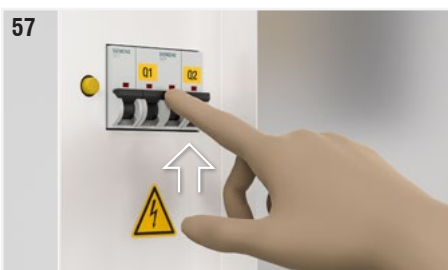
Fig. 57: Verificare che gli interruttori magnetotermici per stacco alimentazione ventilatore (Q1) e stacco alimentazione ausiliari (Q2) siano in posizione ON.
