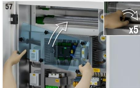
Abb. 58: Sicherstellen, dass die Wärmeschutzschalter zum Abschalten der Lüfterstromversorgung (Q1) und der Hilfsstromversorgung (Q2) auf Position ON stehen.
