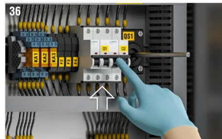
Abb. 36: Sicherstellen, dass die Wärmeschutzschalter zum Abschalten der Lüfterstromversorgung (Q1) und der Hilfsstromversorgung (Q2) auf Position ON stehen.
