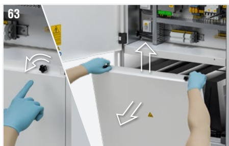
Fig. 63: Desatornille las 2 perillas que mantienen cerrado el panel inferior posterior de acceso para el mantenimiento. Levante y luego tire hacia usted para retire el panel.
