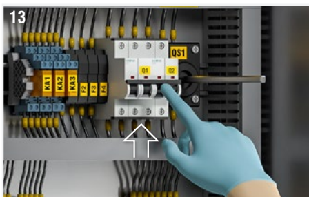
Fig. 13: Compruebe que los interruptores magnetotérmicos para desconectar la alimentación del ventilador (Q1) y desconectar la alimentación auxiliar (Q2) estén en la posición ON.
