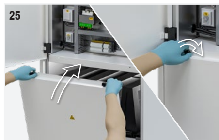
Fig. 25: Vuelva a colocar el panel de cubierta. Vuelva a atornillar las perillas.
