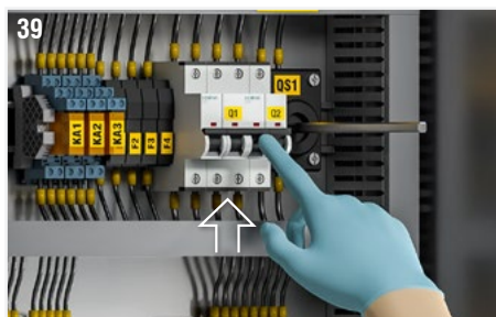
Fig. 39: Compruebe que los interruptores magnetotérmicos para desconectar la alimentación del ventilador (Q1) y desconectar la alimentación auxiliar (Q2) estén en la posición ON.
