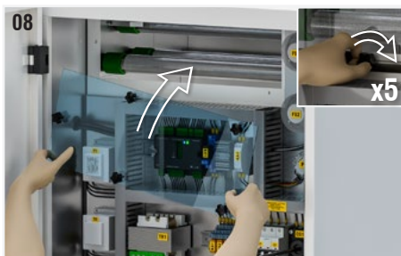
Fig. 8: Vuelva a colocar el panel de plexiglás. Vuelva a atornillar las perillas.
