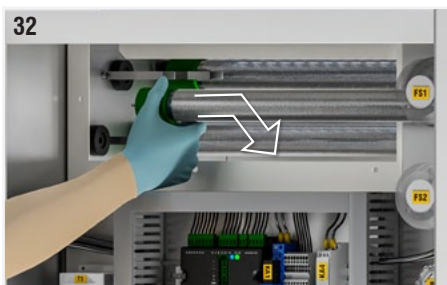
Fig. 32 : Dévisser délicatement le tube ionisant en le saisissant à la base (partie verte).
