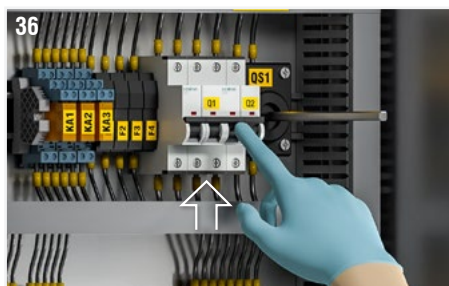
Fig. 36 : Vérifier que les interrupteurs magnétothermiques pour débranchement alimentation ventilateur (Q1) et débranchement alimentation auxiliaires (Q2) soient dans la position ON.
