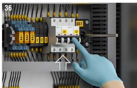
Fig. 36: Verificare che gli interruttori magnetotermici per stacco alimentazione ventilatore (Q1) e stacco alimentazione ausiliari (Q2) siano in posizione ON.
