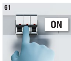
Fig. 61: Agire sul magnetotermico di sicurezza posizionato sul circuito a monte del dispositivo per ripristinare l'alimentazione elettrica.
