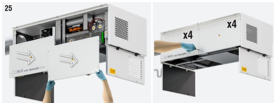
Fig. 25: Rimontare i due pannelli laterali dalla parte del quadro elettrico.
