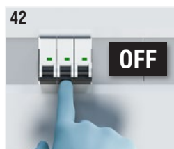
Fig. 42: Sezionare l'alimentazione elettrica agendo sul magnetotermico di sicurezza posizionato sul circuito a monte del dispositivo. Accertarsi che l'alimentazione elettrica non possa essere ripristinata in modo accidentale.
