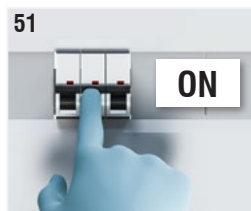
Fig. 51: Agire sul magnetotermico di sicurezza posizionato sul circuito a monte del dispositivo per ripristinare l'alimentazione elettrica.
