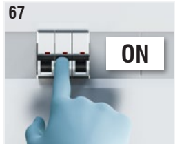
Fig. 67: Agire sul magnetotermico di sicurezza posizionato sul circuito a monte del dispositivo per ripristinare l'alimentazione elettrica.
