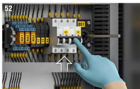
Fig. 52: Verificare che gli interruttori magnetotermici per stacco alimentazione ventilatore (Q1) e stacco alimentazione ausiliari (Q2) siano in posizione ON.
