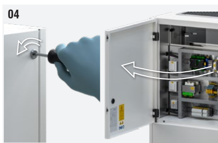
Fig. 4: Utilizzare un cacciavite per aprire il pannello superiore posteriore.
