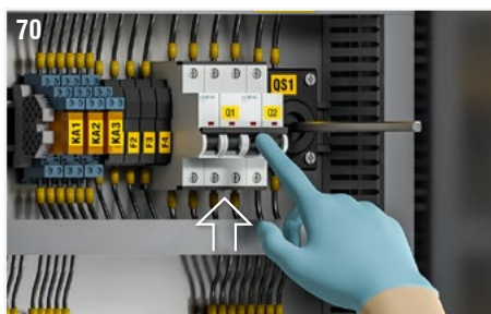
Fig. 70: Verificare che gli interruttori magnetotermici per stacco alimentazione ventilatore (Q1) e stacco alimentazione ausiliari (Q2) siano in posizione ON.
