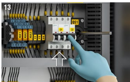
Fig. 13: Verificare che gli interruttori magnetotermici per stacco alimentazione ventilatore (Q1) e stacco alimentazione ausiliari (Q2) siano in posizione ON.
