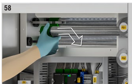
Fig. 58: Svitare delicatamente il tubo ionizzante afferrandolo alla base (parte verde). Se l'operazione risulta difficoltosa, tirare leggermente la molla di messa a terra in modo tale che non faccia contatto con la superficie del tubo.
