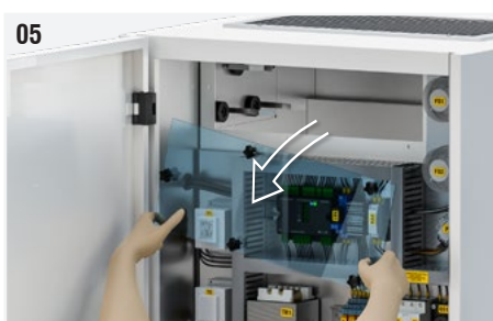
Fig. 5: Svitare le manopole e rimuovere il pannello interno in plexiglass per accedere ai tubi ionizzanti.
